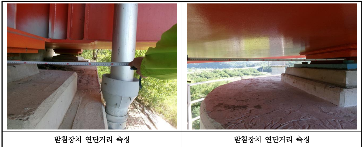
【사진 30.3.15】 교량받침장치 연단거리측정
