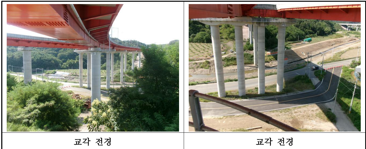
【사진 30.3.10】 교각 전경
