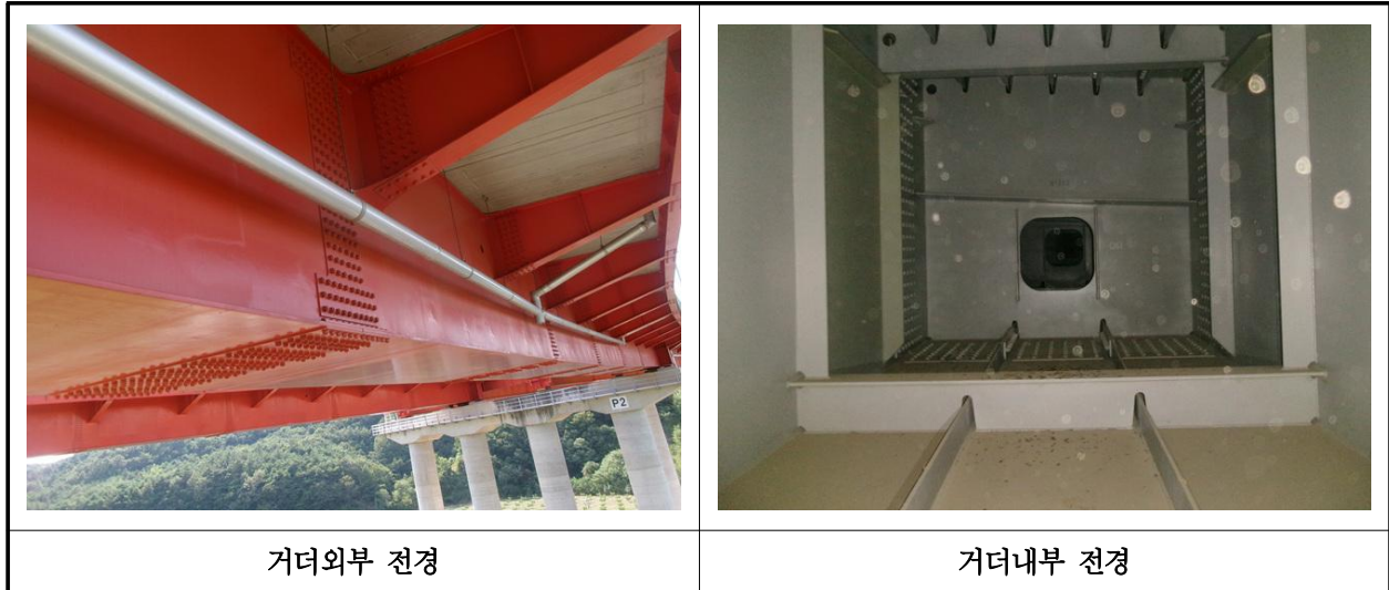
【사진 30.3.4】 거더 전경
