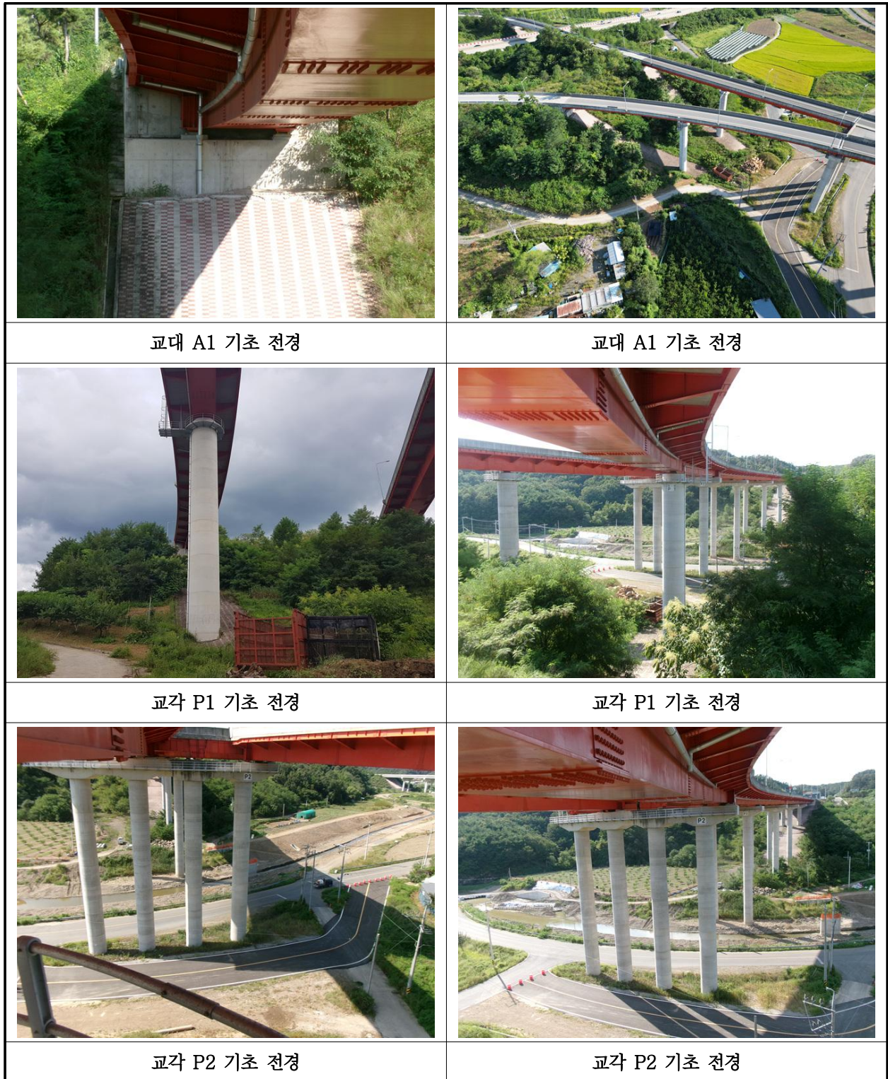
【사진 30.3.12】 기초 전경
