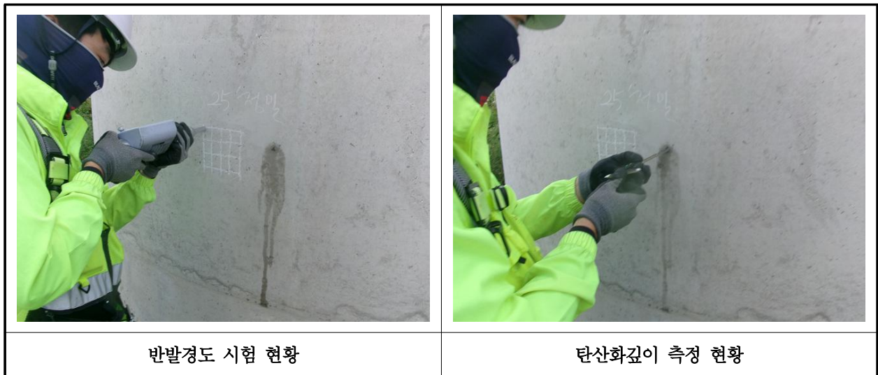
【사진 30.4.1】 콘크리트 내구성조사 현황
