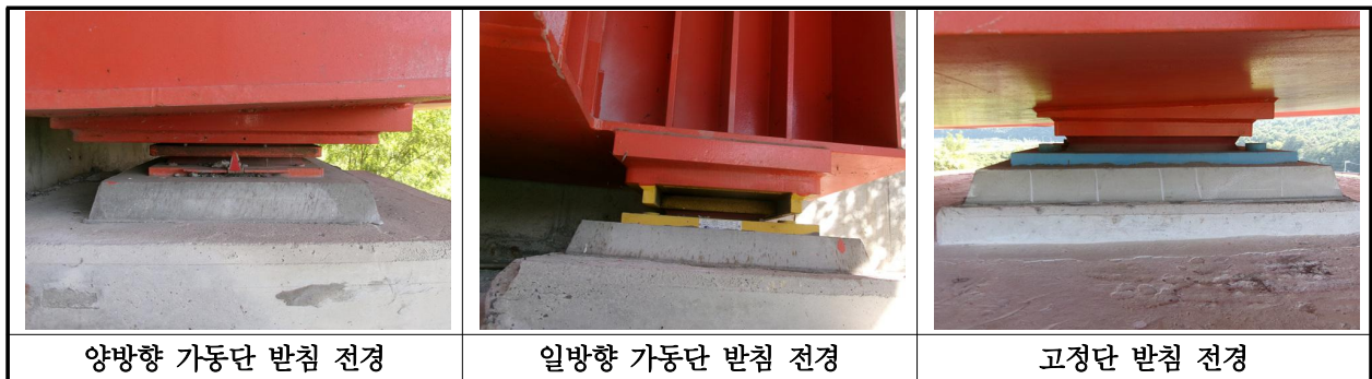
【사진 30.3.13】 교량받침 전경
