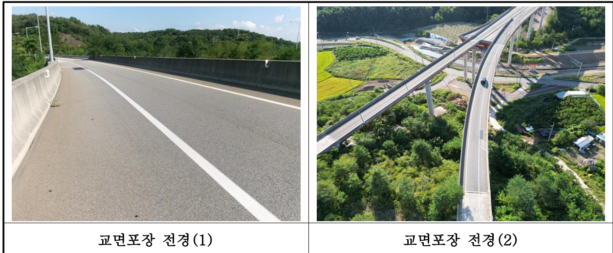
【사진 30.3.20】 교면포장 전경
