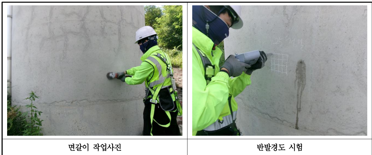
【사진 30.4.2】 반발경도시험 현장사진
