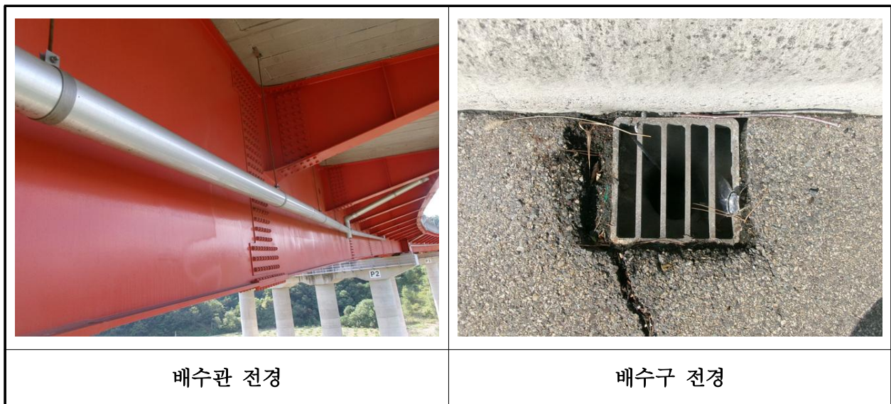
【사진 30.3.22】 배수시설 전경
