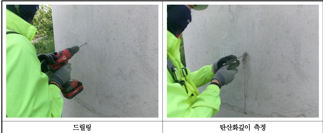
【사진 30.4.3】 탄산화 깊이 측정 현장사진
